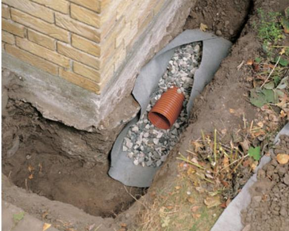
Ilustración 13. Zanja de drenaje. Fuente: (Idroter, 2021)
