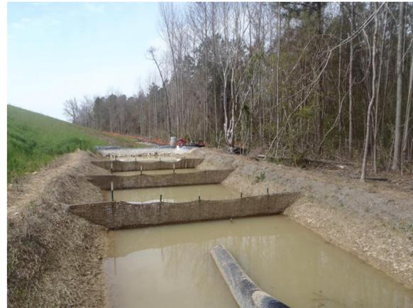
*Ilustración 19. Cuenca sedimentadora con barreras porosas. Fuente: (Little almance Creek, 2016)*
