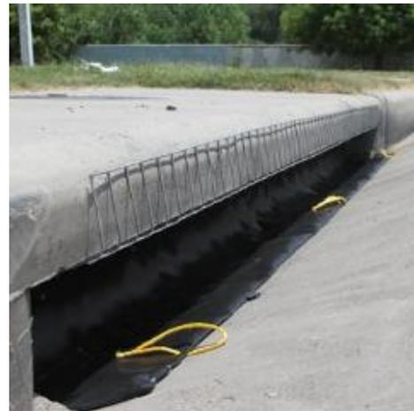
Ilustración 33. Protección de sumidero vertical con filtro drenante Fuente:
