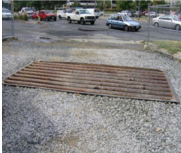
*Ilustración 28. Rack de tuberías. Fuente: (Minnesota Pollution Control Agency, 2019)*
