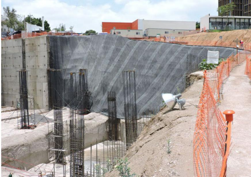
*Ilustración 11. Geomalla sobre talud. Fuente: (MYG-GDL, 2021)*
