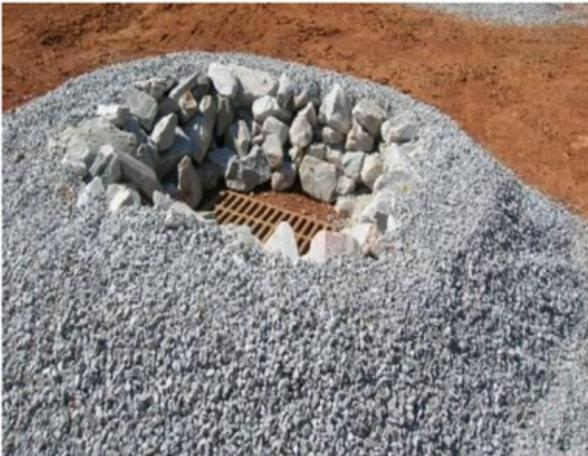
Ilustración 32. Protección de sumidero horizontal en agregado grueso Fuente: (OkState, 2021)
