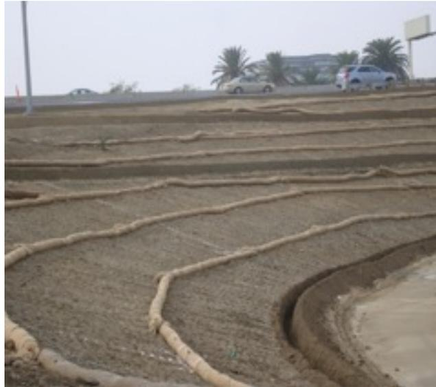
*Ilustración 18. Rollos de fibra con mulching y zanjas para protección de erosión en talud. (An Wil, 2021)*
