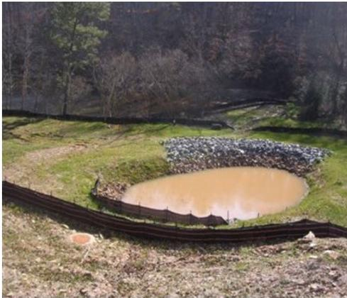
*Ilustración 20. Trampa sedimentadora. Fuente: (Minnesota Pollution Control Agency, 2019)*
