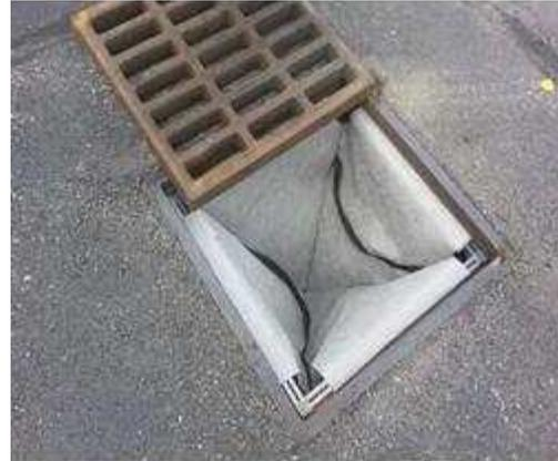
*Ilustración 34. Protección de sumidero horizontal con filtro drenante Fuente: (Estorm water, 2018)*
