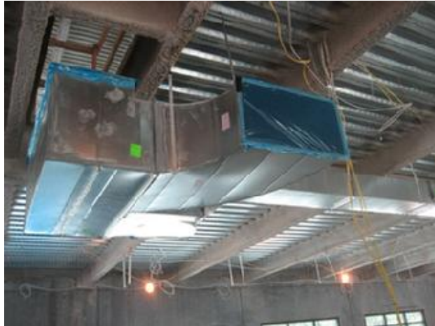
Ilustración 2. Protección de ductos. Fuente: (R.R Simmons, 2021)
